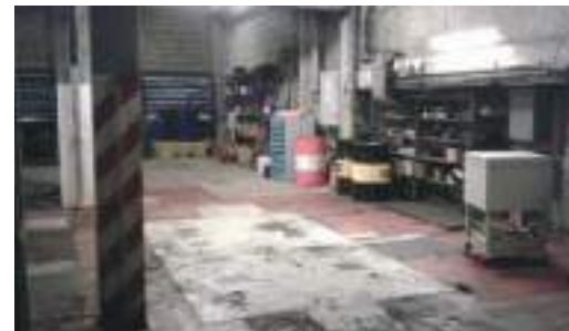
Emplacement de la 4 ème chaudière démantelée - Source : Antea Group, février 2019
