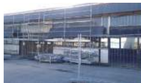
Ancienne buanderie en cours de désamiantage/démolition - Source : Antea Group, février 2019
