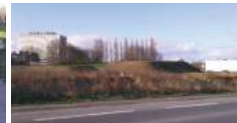
(9) Tas de terre visibles depuis l'avenue Becquerel - Source : Antea Group, février 2019
