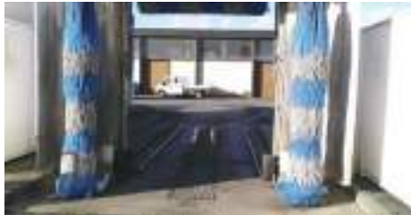
Aire de lavage - Source : Antea Group, février 2019
