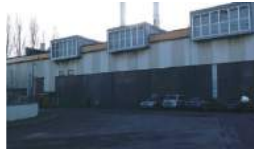
Photographie de la chaufferie - Source : Antea Group, février 2019
