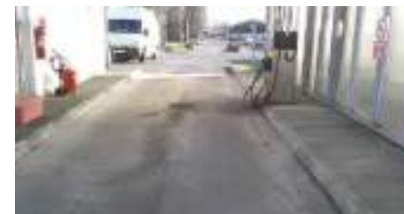
(4) Station service avec cuve bi-compartmentée enterrée - Source : Antea Group, février 2019
