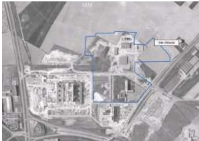
1972 Création du plateau technique: la buanderie, l'atelier et la chaufferie sont en construction. Les cuves aériennes de fuel sont également présentes. Les bâtiments au Sud-Est sont en construction. La partie Est du site est un champ agricole. En dehors du périmètre de projet : les bâtiments principaux du CHU (actuel tour de Nacre et centre F. Baclesse) ainsi que les parkings associés sont en construction.
