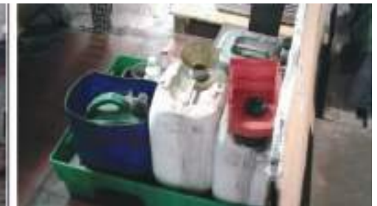
Produits d'entretien pour les chaudières (placés sur bac de rétention) - Source : Antea Group, février 2019
