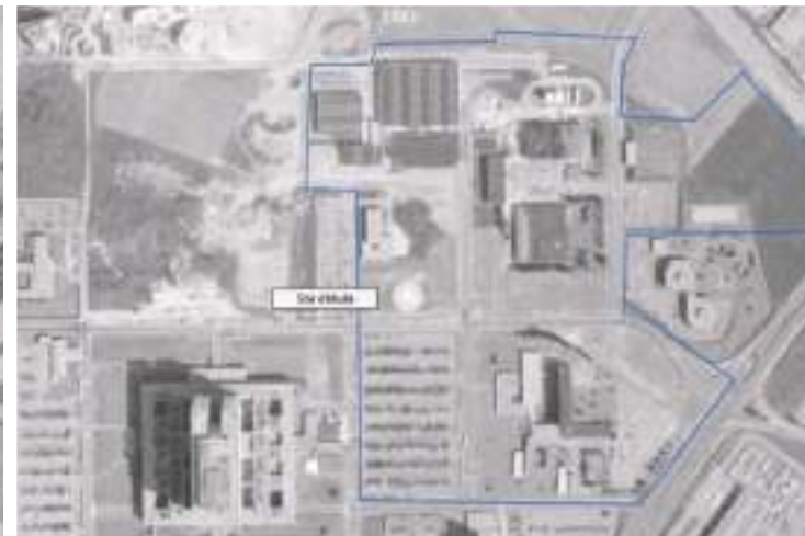
1983 L'entrepôt général, les archives, le magasin technique, le local des produits dangereux et l'internat sont construits. Les parkings Est et Ouest sont également visibles (respectivement actuels parking P3 et P8). L'hélisurface et l'ensemble des bâtiments au Sud-Est sont construits. Le site est dans son état actuel. En dehors du périmètre de projet : l'expansion du CHU continue, notamment avec la création des bâtiments au Nord du site (enseignement).
