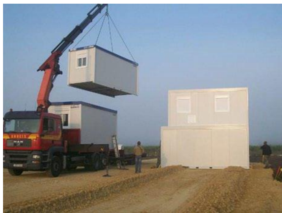
Figure 4 : Exemple de poste de livraison (source : NEOEN, 2018)
