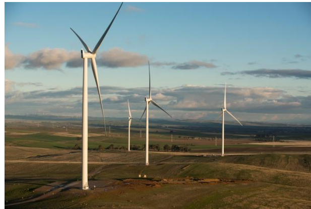
Figure 14 : Parc éolien de Hornsdale 1 – juillet 2016
