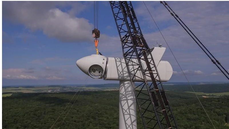
Figure 18 : Installation du moyeu sur l'éolienne n°6 (source : Neoen, 2017)
