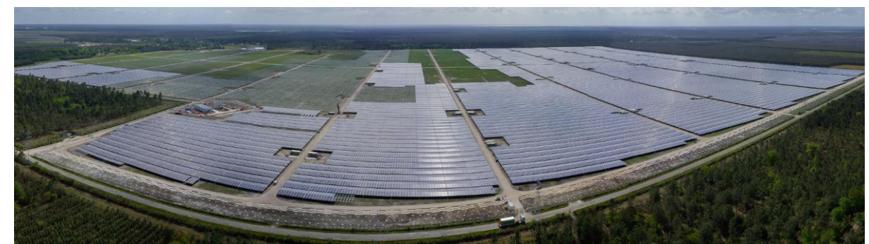
Figure 13 : Parc photovoltaïque de Cestas en construction – mai 2015 (source : Neoen, 2017)
