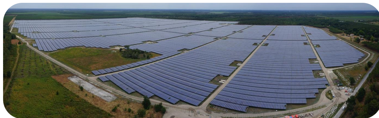
Figure 11 : Chantier de la centrale photovoltaïque de Cestas (300 MWc) (source : Neoen, 2017)
