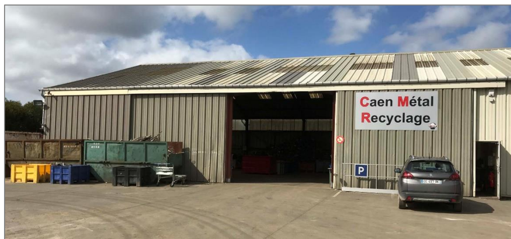
Vue du bâtiment d'exploitation
