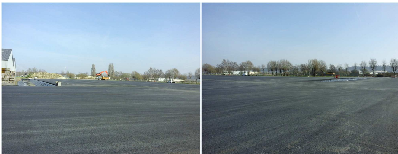
Photographies 3 et 4 : Future zone d'extension des activités, en cours d'aménagement par le GPMR (date de photographie : 23 mars 2021)
