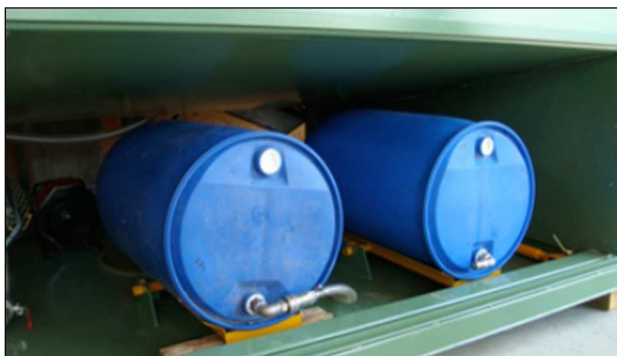
Photographie 5 : Vue de deux fûts de 215 litres de produits concentrés placés sur rétention dans une cabine d'aspersion
