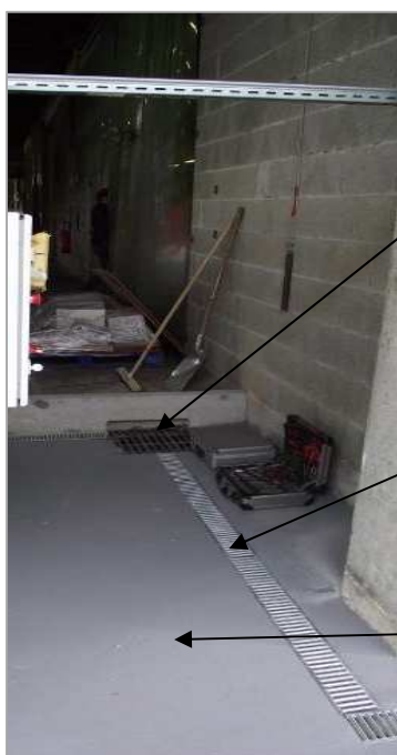
Photographie 4 : Vue d'un dispositif de collecte des égouttures ou déversement accidentel
