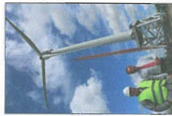
Une grue de 160 m, près de l'éolienne.
