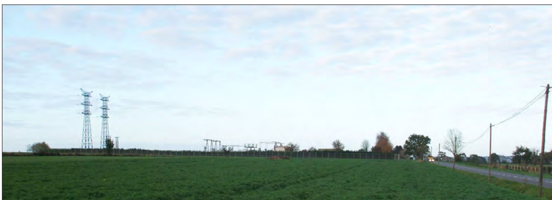
Exemple d'un poste 90/20 000 volts entouré d'une haie du type de celui de Fontaine-Etoupefour
