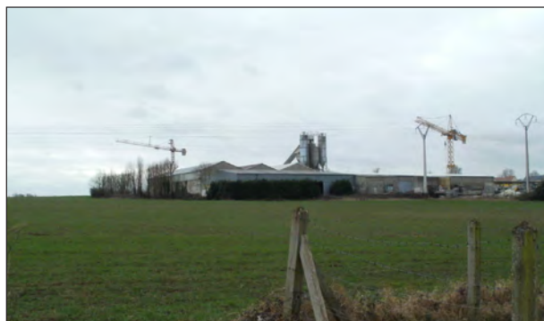
Terrain du futur poste de Fontaine-Étoupefour à l'est du parc d'activités
