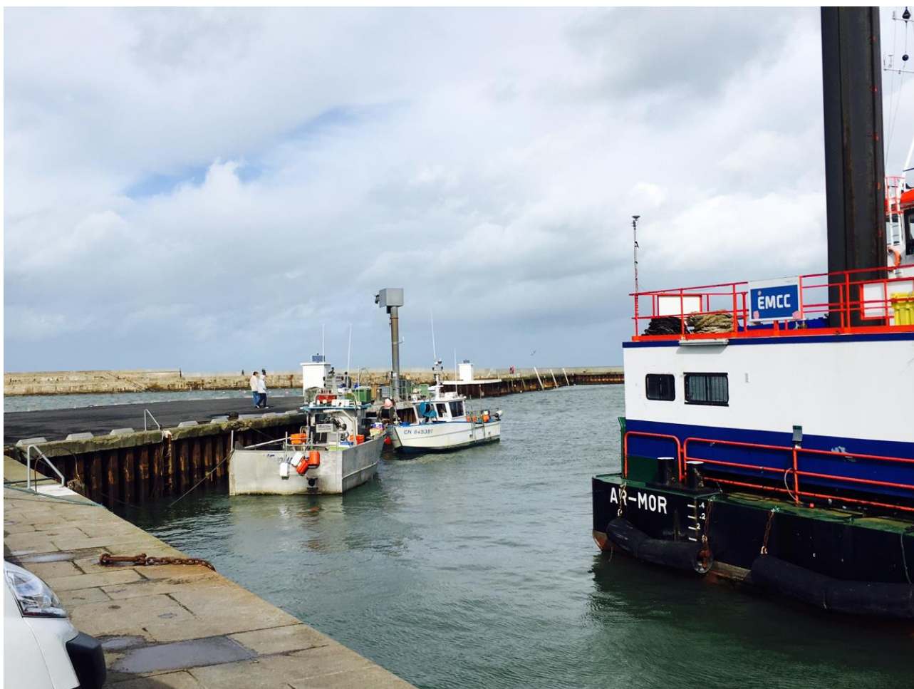
Les épis ouest (à gauche) et est (en haut vers la droite) du port de Port-en-Bessin-Huppain
