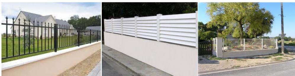
Mur bahut surmonté d'une grille / Mur bahut et palissade / Mur bahut et grillage
