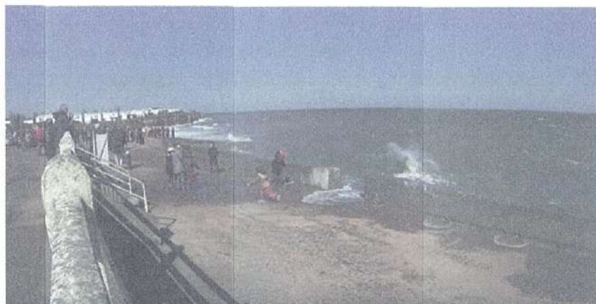
Figure II.5: Vue sur la digue du Boulevard Maritime à Lion-sur-Mer, prise en Mars 2015 (source : Youtube, 2016)
