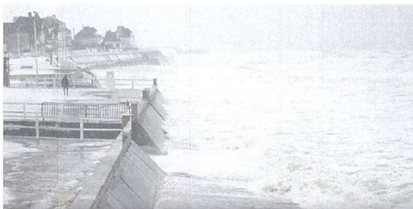
Figure II.4: Vue sur la digue du Bd. Maritime (arrière-plan), prise à partir de la digue du Bas Lion (avant plan) vers l'Ouest, lors d'une tempête (source : Youtube, 2016 date mentionnée de la tempête : 12 mars 2013)
