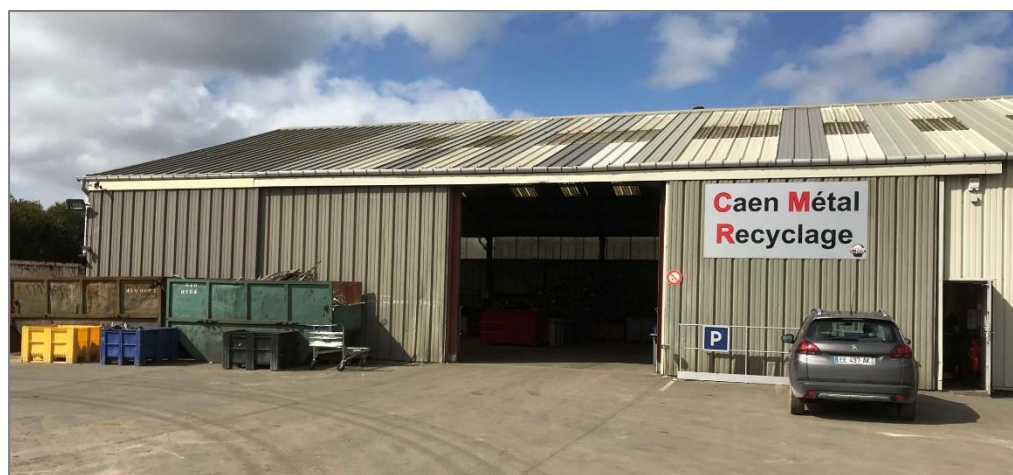
Vue du bâtiment d'exploitation
