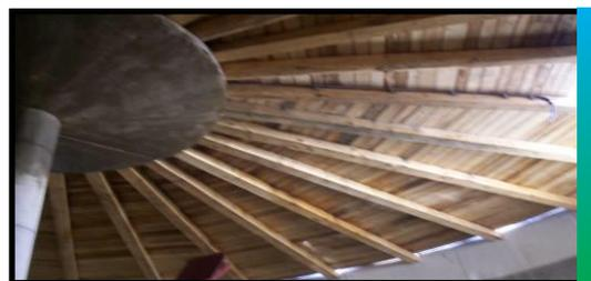
La charpente est constituée de poutres avec un plancher ajouré fixé dessus. Sa structure (section, épaisseur) est déterminée spécifiquement selon les caractéristiques du digesteur/post-digesteur par des calculs statiques.
