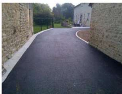
Cour en enrobé
