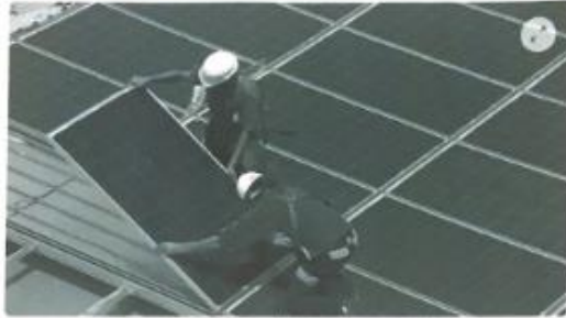
Le parc photovoltaïque prévoit des modules sur une ancienne décharge. (4/20/21)
