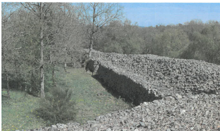
Angle sud-est des remparts
