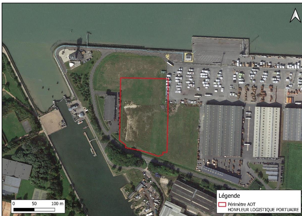
Figure 2 : Vue aérienne du projet
