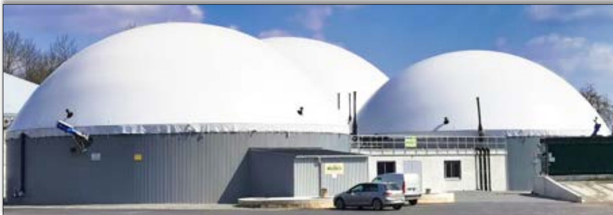
Exemple d'image : Toits à doubles membranes gris de forme sphérique pour le stockage de biogaz sur des cuves en béton
