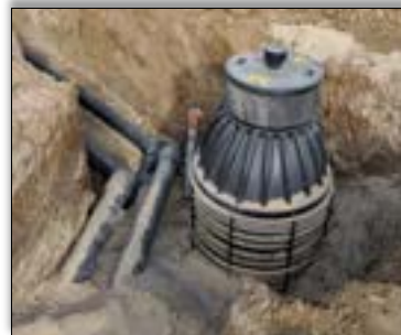
Exemple d'image: Bac à condensat
