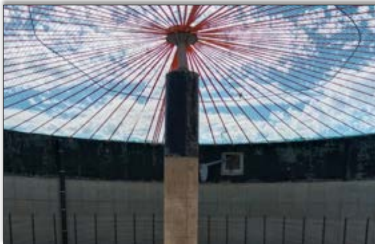
Exemple d'image: construction du support de sangles
