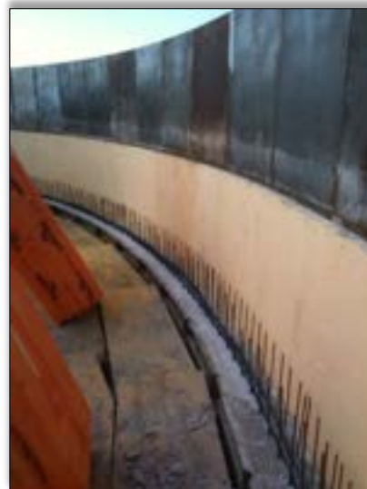
Exemple d'image: Isolation sur la paroi
