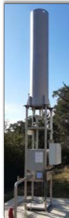
Exemple d'image: Torchère de biogaz
