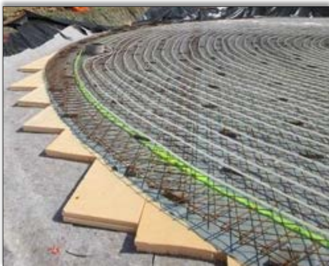
Exemple d'image: Isolation sous le radier
