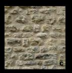
Cette mise en œuvre permet de **protéger** la pierre calcaire et de freiner sa dégradation. Au fil du temps, les joints se creusent **naturellement** et la pierre réapparaît (b).
