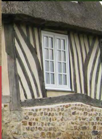
Dans le Pays d'Auge, de **nombreux matériaux** s'associent au pan de bois pour le protéger de l'eau. L'ossature peut être comblée par de la **brique** (a) ou par du **tuileau**, mais plus souvent par du **torchis**. Ce dernier est alors recouvert par un **enduit à la chaux**. Lorsque toute la façade est protégée, on trouve un **essentage** soit d'**ardoises** (b), soit de **bois** (c). La **Pierre** est systématiquement présente en soubassement.
