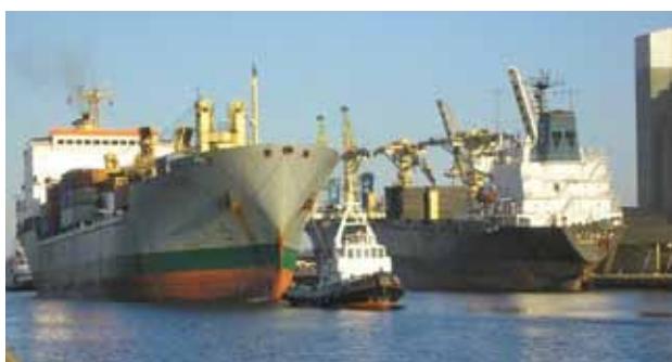
Rénovation du port de Caen-Ouistreham.
