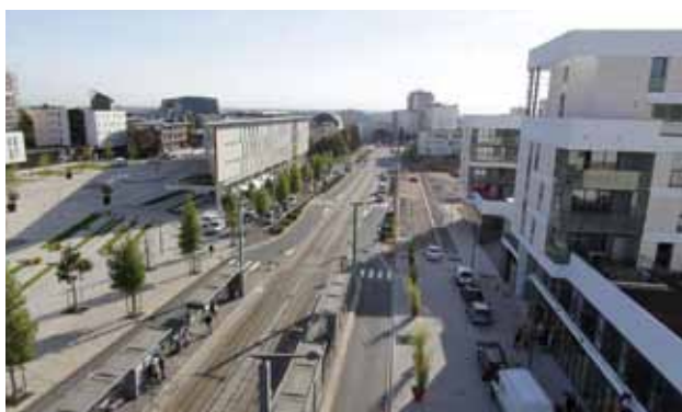
Rénovation urbaine, av. de la Grande Cavée, à Hérouville-Saint-Clair.
