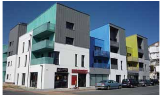
Construction de logements sociaux place Mitterand à Colombelles.
